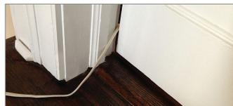
En conexiones eléctricas inadecuadas o cables dañados por puertas cerradas sobre ellos
