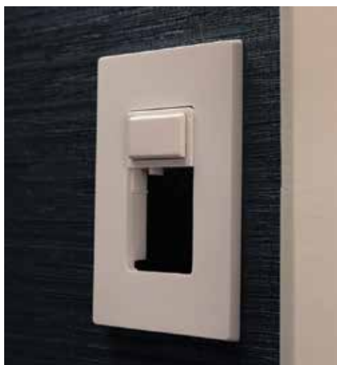
Remove existing module.
