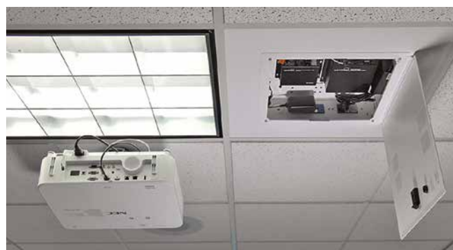
Caja de 35.5 cm (14 pulgadas) de Centro STRUCTURED MEDIA con equipo de montaje en techo (47612-CMK)
