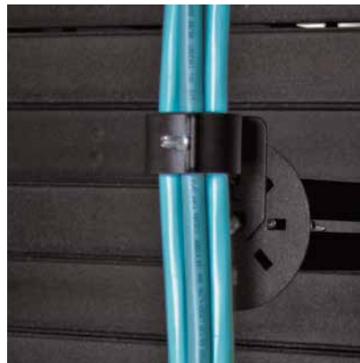
Equipo de sujeción universal de montaje en rack instalado
