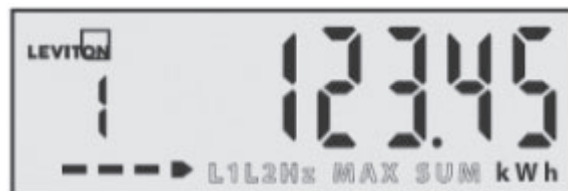
Écran 1 montrant l'énergie réelle (aucune condition d'erreur)
