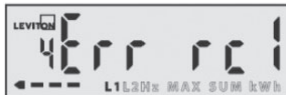
Écran montrant une erreur d'installation (inversion de courant) sur la ligne 1
